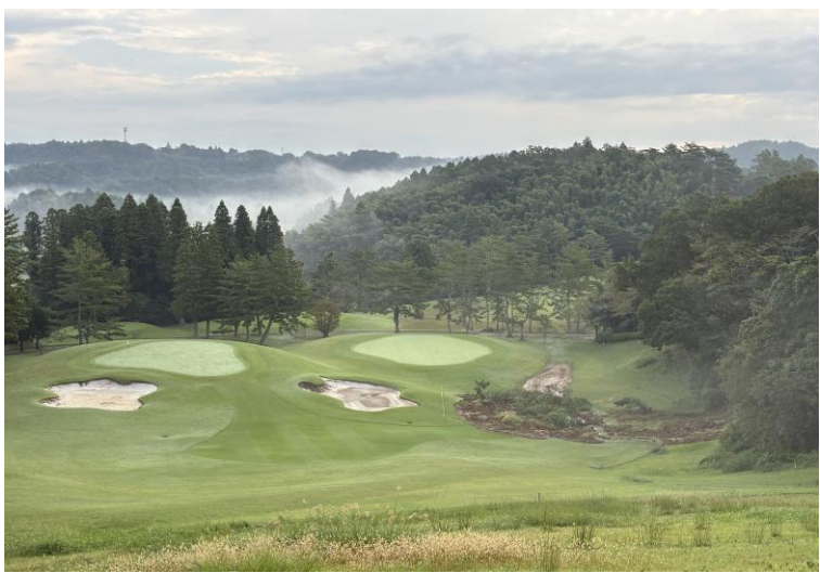
西 6 番ホール 右グリーン側 斜面崩落
